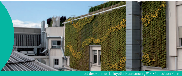
Toit des Galeries Lafayette Haussmann, 9 e / Réalisation Paris
